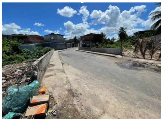
Fotografia 6: Ponte na Rua Carajás – Camaçari/BA, em 14/04/2025.
