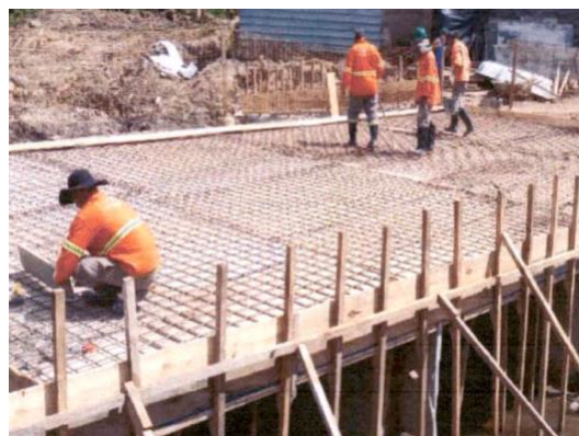
Figura 2: Recorte de fotografia de execução de ponte na Rua Carajás.
