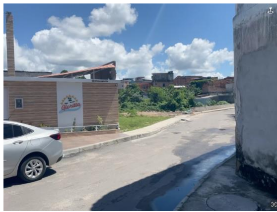
Fotografia 5 Local de execução de rede de drenagem na Rua Carajás (vista oposta do acesso a ponte) – Camaçari/BA, em 14/04/2025.
