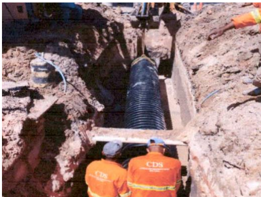
Figura 1: Recorte de fotografia de ampliação da rede de drenagem na Av. Concêntrica.
