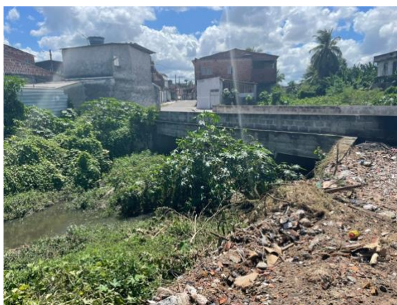
Fotografia 1: Ponte na Rua Carajás. Camaçari/BA, em 14/04/2025.
