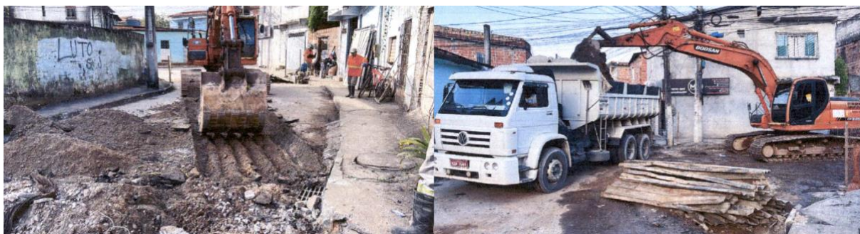
Figura 7: Recorte de registro fotográfico na Rua Curió, onde foi pago transporte de material demolido com carrinhos de mão (jericas).
