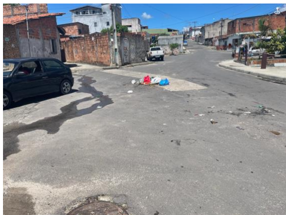
Fotografia 4: Local de execução de rede de drenagem na Rua Carajás – Camaçari/BA, em 14/04/2025.
