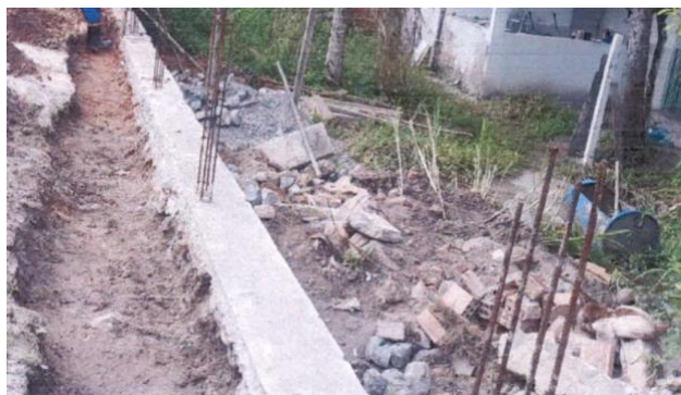
Figura 13: Recorte de registro fotográfico da Rua Santa Rita, referente à execução de um muro em alvenaria de pedra.
