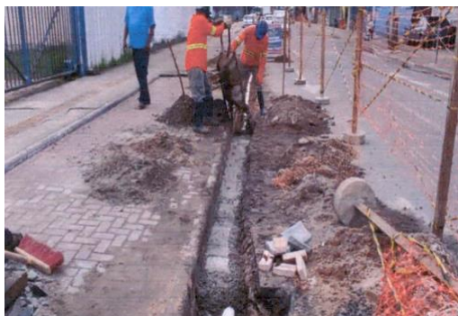
Figura 9: Exemplo de situação em que se justifica a escavação manual, na Rua Jorge Amado, pelo menor volume e existência de interferências.
