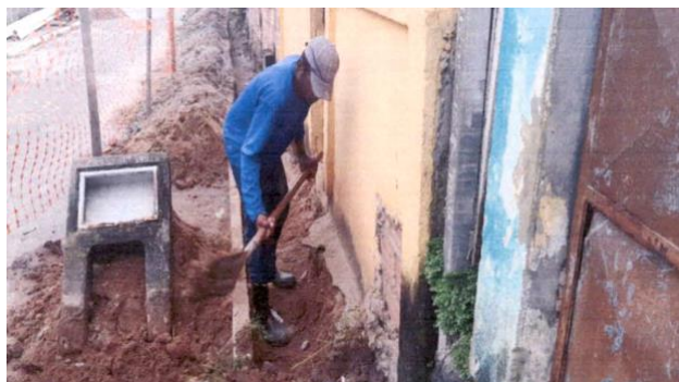
Figura 10: Exemplo de situação em que se justifica a escavação manual, na Rua do Cruzeiro, pela existência de interferências.
