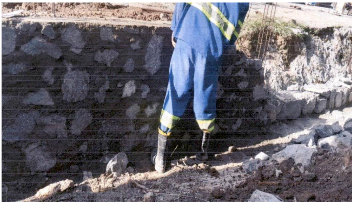
Figura 5: Recorte de fotografia de execução de alvenaria de pedra na Rua Santa Rita, em Camaçari/BA.
