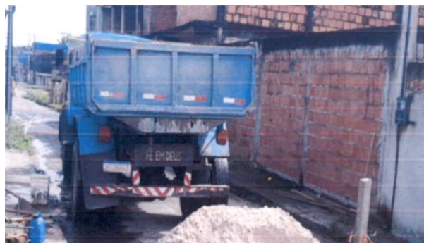
Figura 8 Recorte de registro fotográfico na Rua Curió, onde foi pago transporte de material demolido com carrinhos de mão (jericas).
