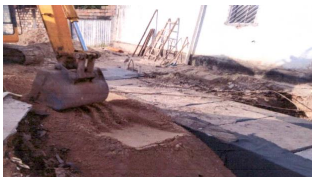
Figura 11: Aterro mecanizado na Rua Carajás, onde foi paga escavação manual.
