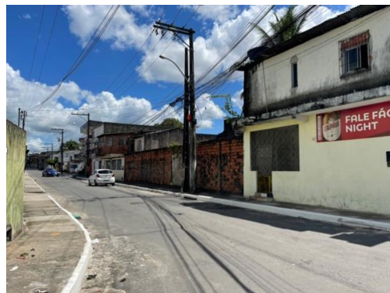
Fotografia 3: Trecho com remuneração de transporte vertical na Rua Curió – Camaçari/BA, em 14/04/2025.
