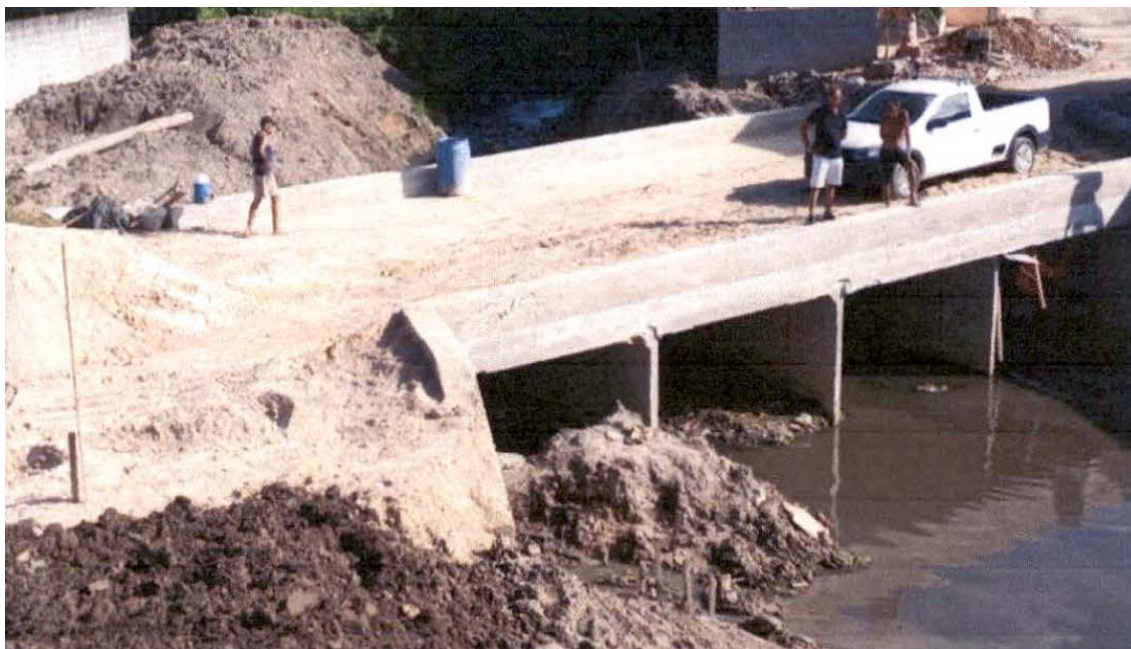
Figura 4: Recorte de fotografia de ponte executada na Rua Carajás, em Camaçari/BA.
